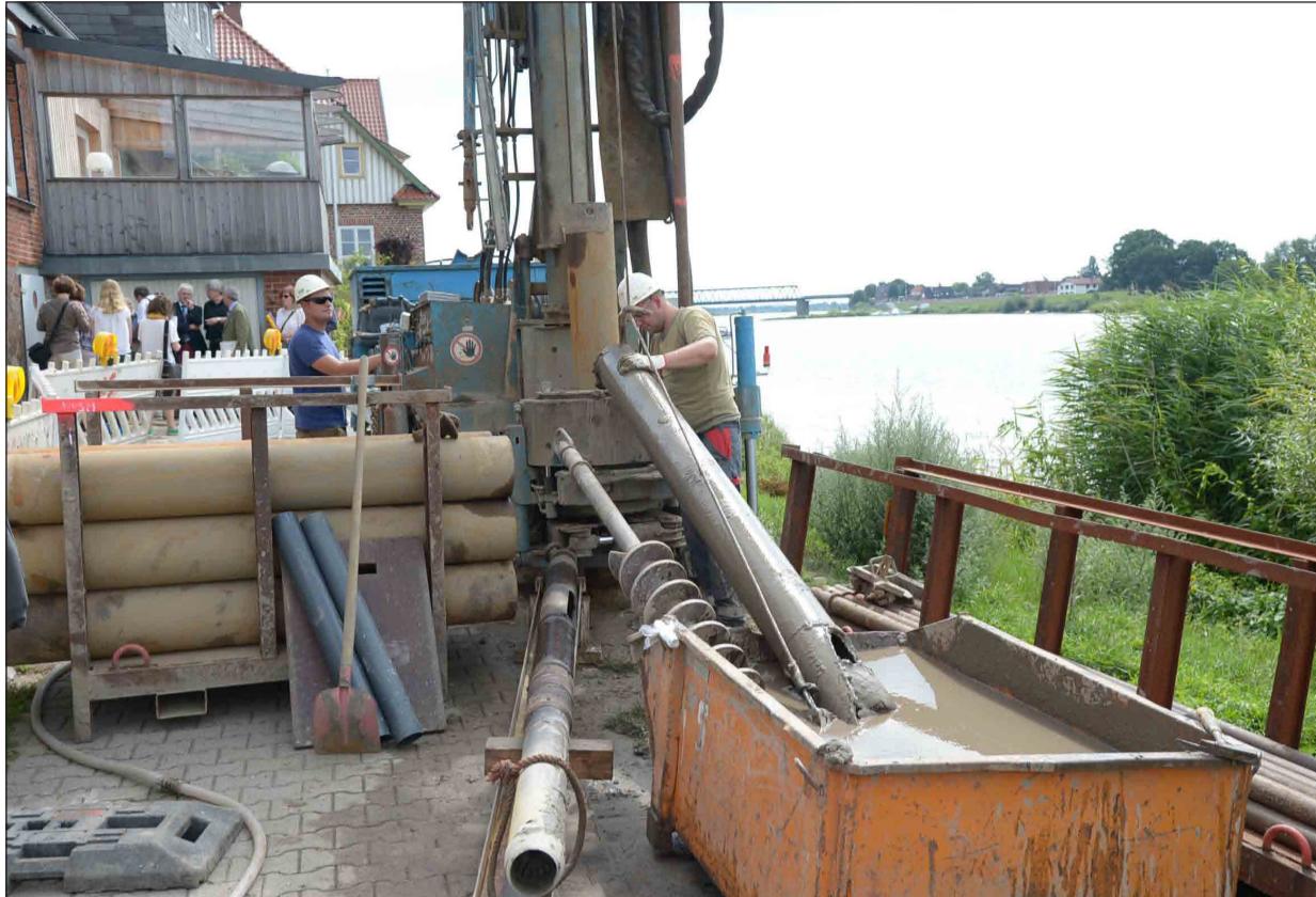
Sean Marshall, Michael Zierke und weitere Kollegen haben in dieser Woche in Lauenburg mit Bohrungen bis in 50 Meter Tiefe begonnen. Ab kommender Woche wird auch von im Wasser befestigten Pontons gebohrt. Fotos: be
